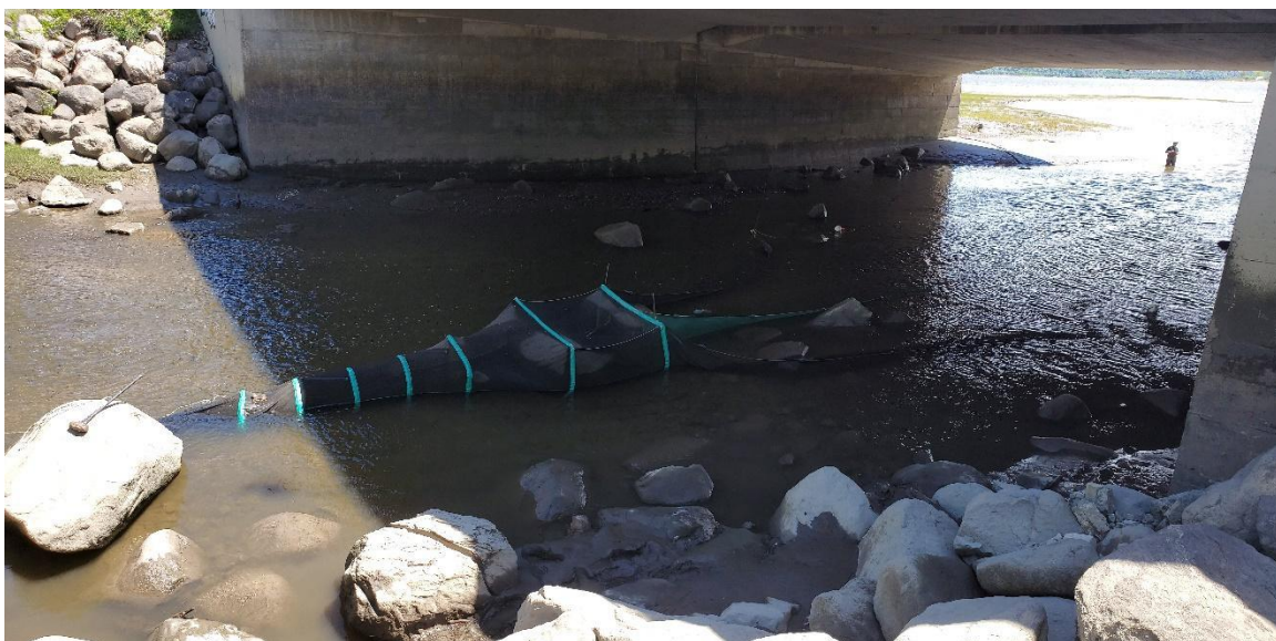
Figure 8 : Installation d'une trappe Alaska face vers l'aval du cours d'eau. (Source : OBVC)
