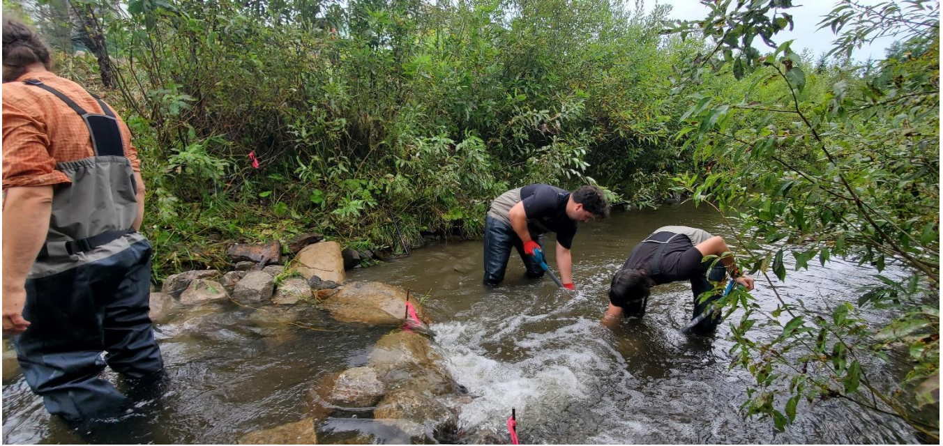
Figure 4 : Aménagement de la fosse en aval du seuil dans le lit de la rivière du Berger.
