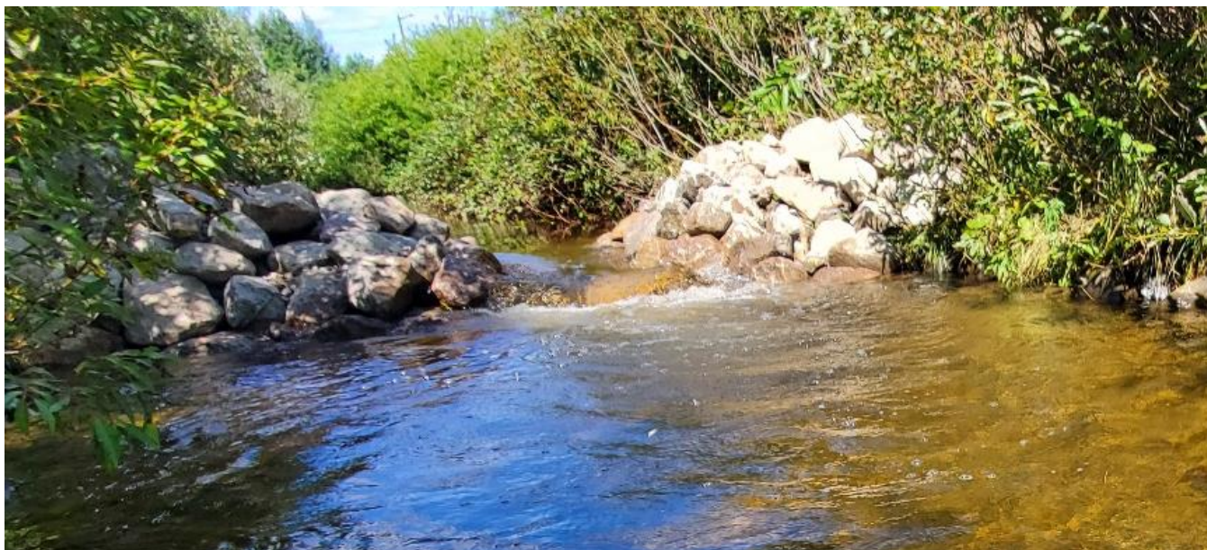
Figure 3 : Seuil aménagé dans la rivière du Berger le 31 août et 15 septembre 2023.
