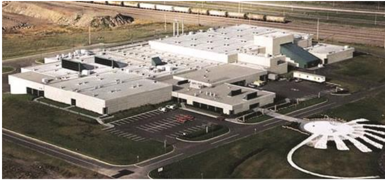
Figure 5.14.2.3.1 : Vue aérienne de la station Est d'épuration des eaux usées © CUQ
