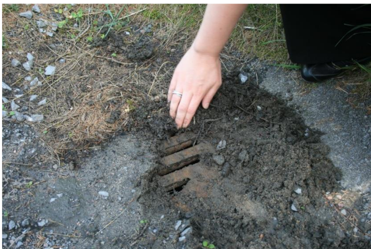
Figure 2.8.3: Recouvrement d'un regard d'égout pluvial par les sédiments dans le bassin de la rivière Jaune
