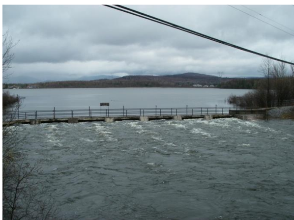
Figure 5.8.1.2 : Barrage Cyrille-Delage en période de crue printanière
