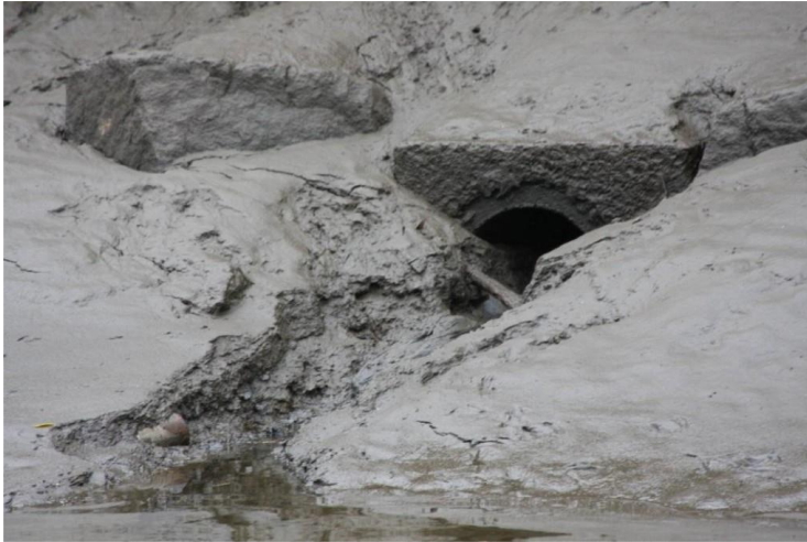
Figure 2.8.5: Envasement d'une conduite pluviale se déversant dans la rivière Saint-Charles. © Phillipe-Hubert Roy-Gosselin
