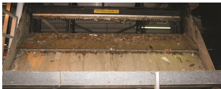
Figure 5.14.2.3.2 : Dégrilleur à la station de traitement des eaux usées Est © CBRSC, 2005
