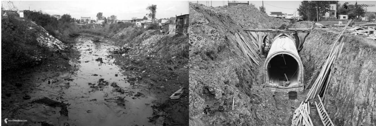
Figure 2.1.2: Rivièrè Lairet avant la canalisation et pendant les travaux. Tiré des archives de la Ville de Québec et vu dans le blogue monlimoilou.com.
