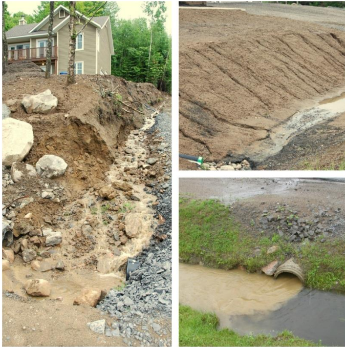
Figure 5.6.1.2: Illustration de l'érosion sur les chantiers de construction et de l'effet sur les cours d'eau. Photos: APEL
